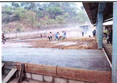
Foto 3: CONSTRUCCION Y SUMINISTRO DE LOSA DE CONCRETO
