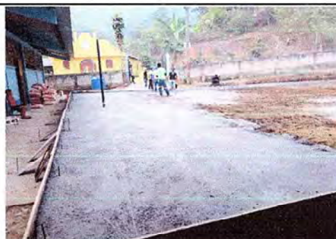
Foto 4: CONSTRUCCION Y SUMINISTRO DE LOSA DE CONCRETO
