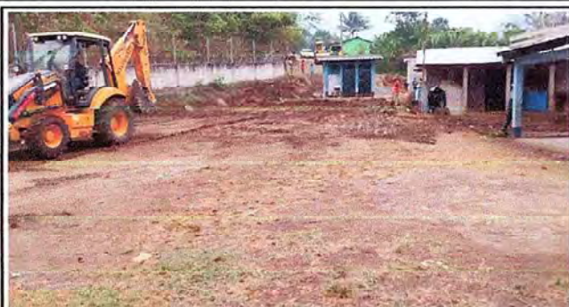
Foto 1: PREPARACION AREA PARA COLOCACION DE LOSA DE CONCRETO
