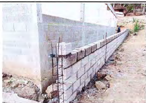
Foto 5: CONSTRUCCION Y SUMINISTRO DE MURO PERIMETRAL
