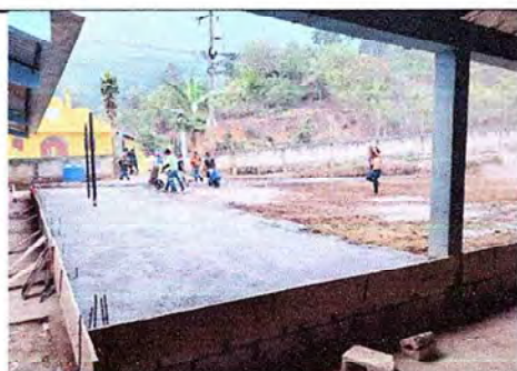
Foto 5: CONSTRUCCION Y SUMINISTRO DE LOSA DE CONCRETO
