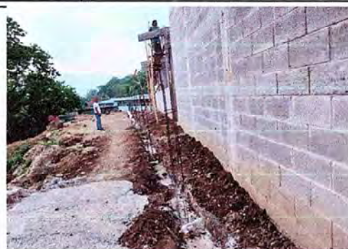
Foto 2: CONSTRUCCION Y SUMINISTRO DE MURO PERIMETRAL
