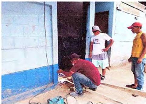
Foto1: MODULO 4; SUSTITUCION DE PUERTA DE METAL.
