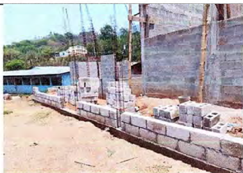
Foto 3: CONSTRUCCION Y SUMINISTRO DE MURO PERIMETRAL
