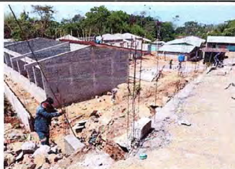
Foto 4: CONSTRUCCION Y SUMINISTRO DE MURO PERIMETRAL
