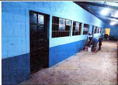
Foto 3: PINTURA EN MURO INTERIORES Y EXTERIORES (DOS MASNOS)
