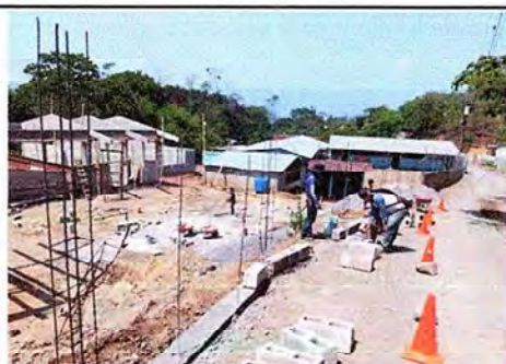
Foto 6: CONSTRUCCION Y SUMINISTRO DE MURO PERIMETRAL
