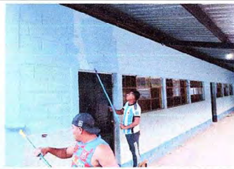
Foto 2: PINTURA EN MURO INTERIORES Y EXTERIORES (DOS MASNOS)
