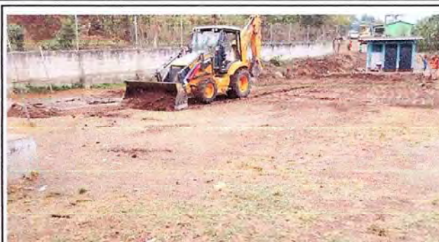
Foto 2: PREPARACION DE AREA PARA LA CONSTRUCCION DE LOSA DE CONCRETO
