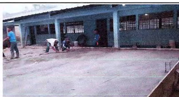
Foto 6: CONSTRUCCION Y SUMINISTRO DE LOSA DE CONCRETO
